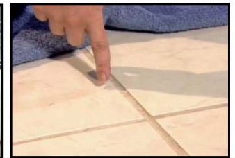
2. Tidak ada kotoran yang tertinggal di Lantai.
